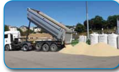
27.07.20: Verfüllmaterial für die Oberfläche wurde geliefert und auch verteilt (Kork und Quarzsand).
