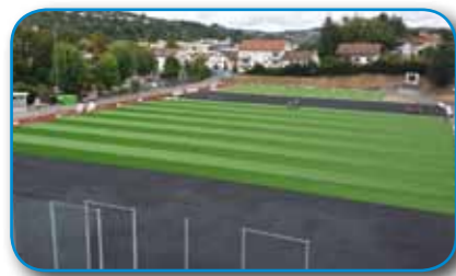
Abtragen des alten Rasenbelags
